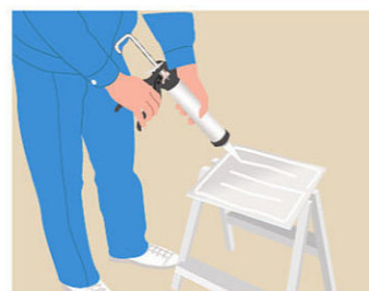
Нанесение строительного клея полосками
