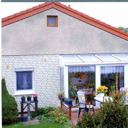
Перед реставрацией панелями виниПлюс ПДП
